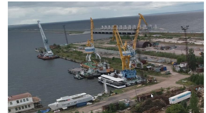
02 | СУЩЕСТВУЮЩИЕ СТРЕЛОВЫЕ КРАНЫ | EXISTING CRANES
